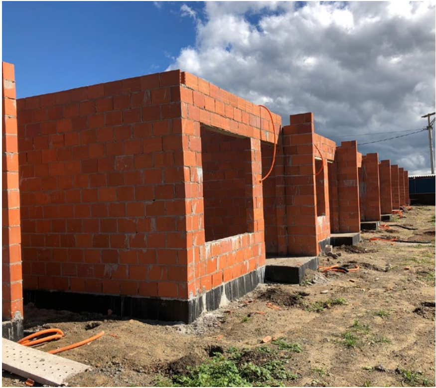
Obra com alvenaria racionalizada, com blocos da Cerâmica Argibem
