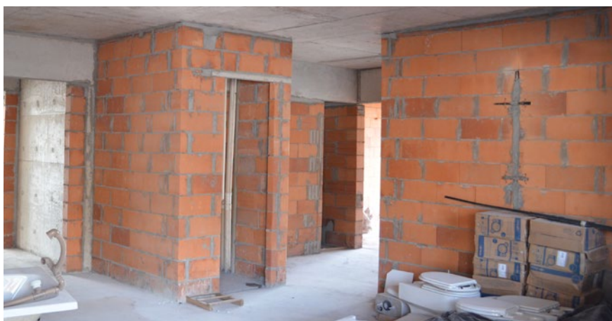
Alvenaria em execução com blocos da Cerâmica City
