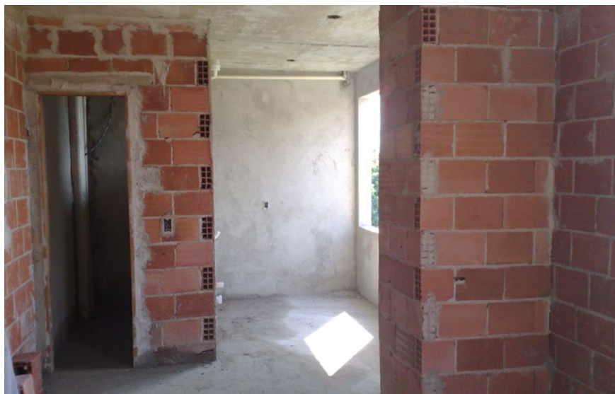
Obra com alvenaria de vedação horizontal
