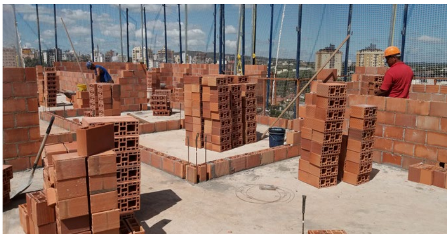
Alvenaria em execução com blocos da Pauluzzi Blocos Cerâmicos
