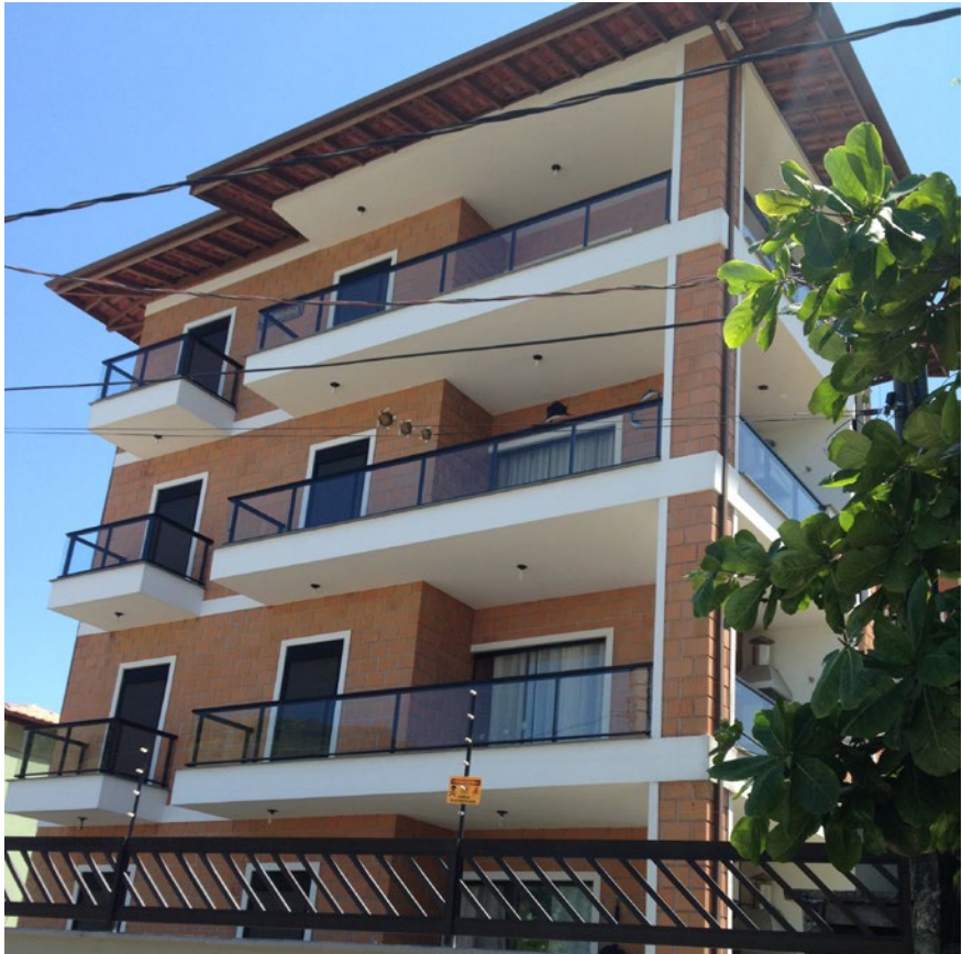
Edifício construído com blocos da Selecta
